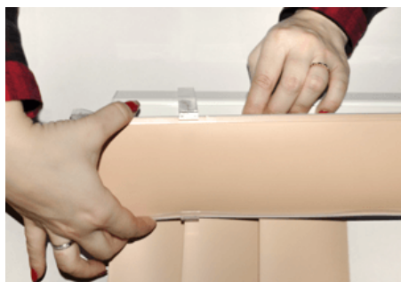
4. Установите ламбрекен на кронштейны для ламбрекена.
